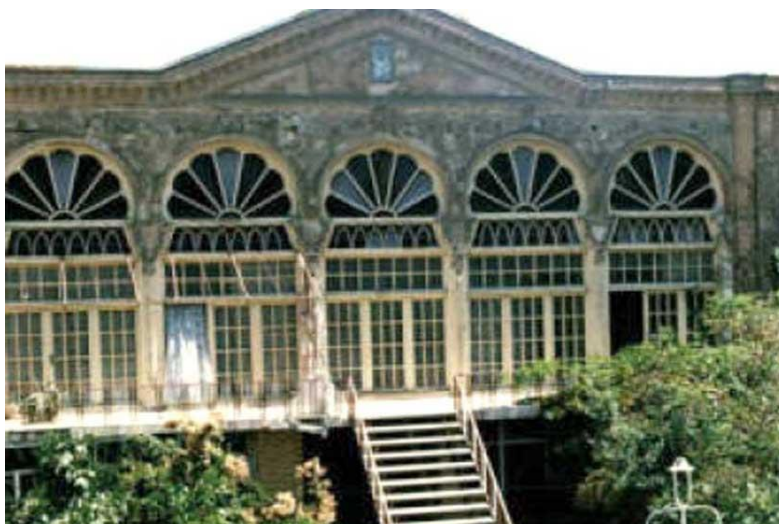
تصویر ۳: نمای رو به حیاط بیرونی خانه سرخه‌ای، پیش از آغاز عملیات مرمت، که در آن اصالت گچبری‌های نما مشخص است (آرشیو اداره کل میراث فرهنگی استان آذربایجان شرقی).
